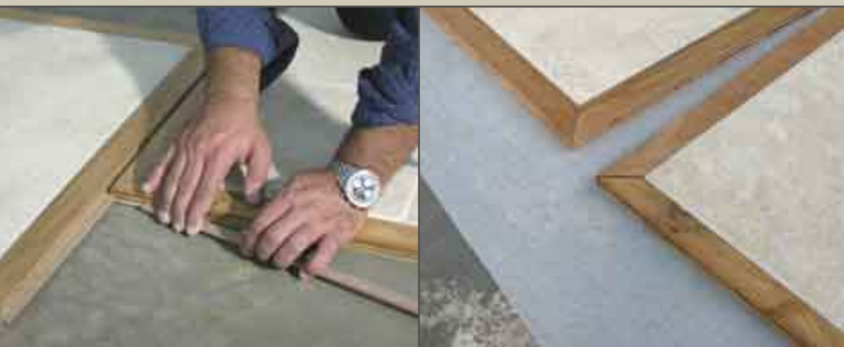
Particolare del sistema di incastro dei pannelli e applicazione di tessuto fonoassorbente tra pavimento e massetto.
