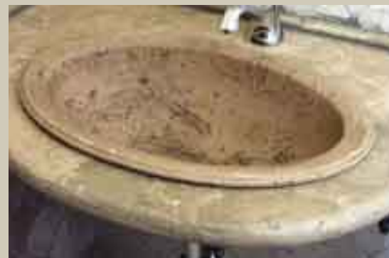
Piano in travertino imperiale con lavello in travertino ricomposto.
